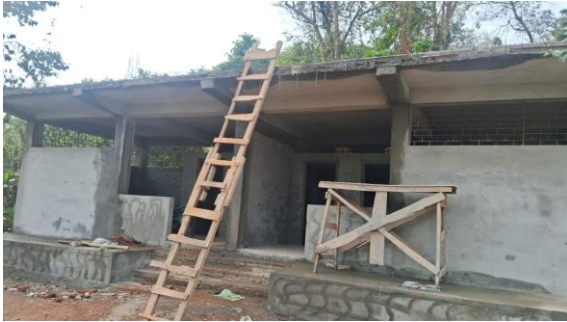
Toiletten werden für die Schulkinder gebaut
